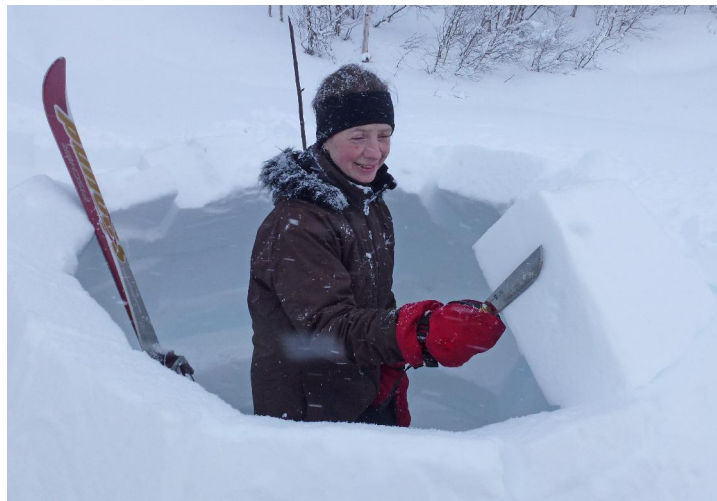
5. Samekniv kan brukes for fintilpassning. Her støtter skien midlertidig opp veggen.
