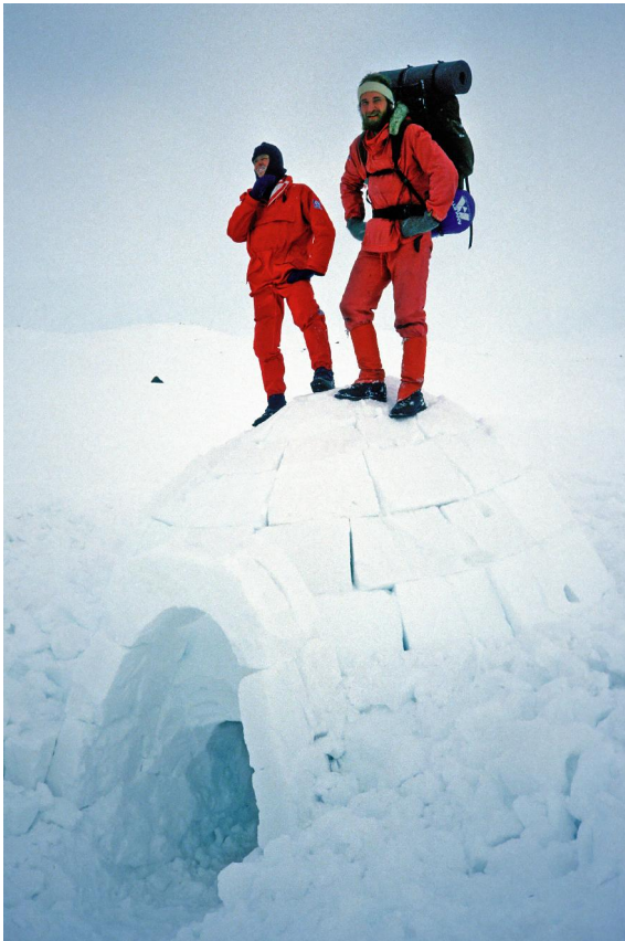
4. Spiralformen gjør at neste blokk fester seg sidelengs til den forrige. Hele flatene skal ligge inntil hverandre!
