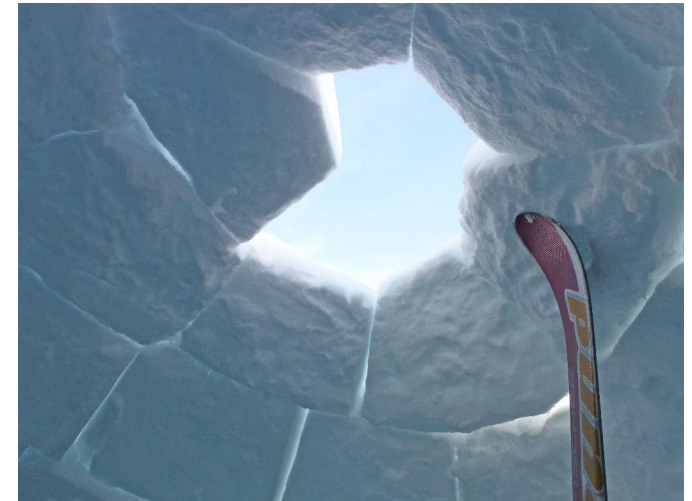
6. Trangere åpning mot slutten krever spesialtilpassede blokker. Skien støtter.
