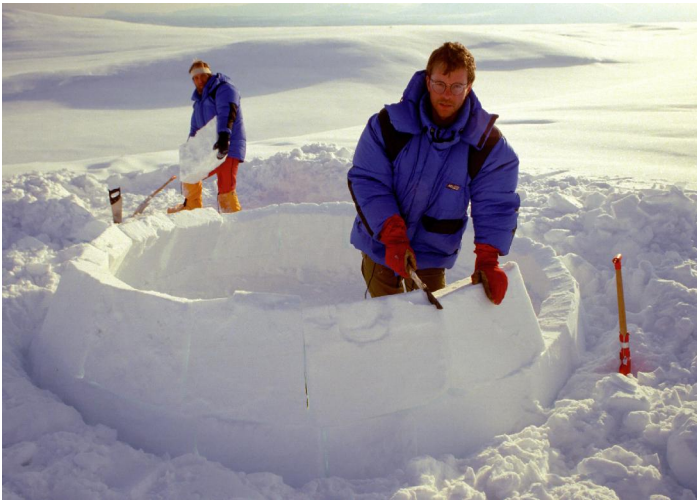
4. Spiralformen gjør at neste blokk fester seg sidelengs til den forrige. Hele flatene skal ligge inntil hverandre!
